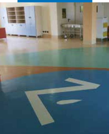
Esempio di posa di PVC in ambienti di lunga degenza - Casa di Riposo San Martino - Italia
